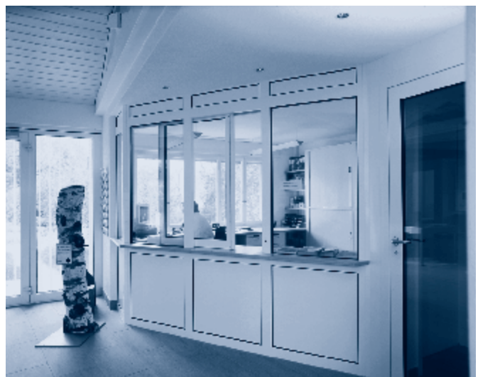
StopFlamm® R.30 in einem Museum Installation StopFlamm® R.30 dans un musée
